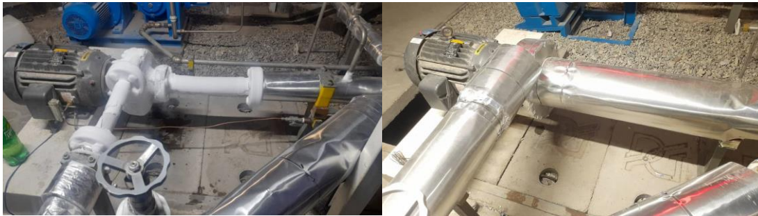
شکل ۱۲- عایق‌کاری آنلاین بلنکت آبروژل در خطوط پمپاژ اکسیژن مایع با دمای منفی ۱۸۲ درجه سلسیوس
