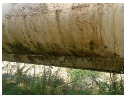
شکل ۲۰- کندانس شدن رطوبت روی خطوط ال ان جی عسلویه و زنگ زدگی و رشد میکروارگانیسمها روی عایق
