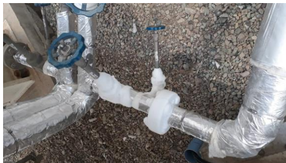
شکل ۱۳- عایق‌کاری خطوط منفی ۱۸۲ درجه سلسیوس اکسیژن مایع در ضخامت‌های مختلف ۱، ۲، ۳ و ۴ سانت (با ضخامت یک سانت دمای سیال به حدود دمای محیط در سطح عایق کاهش می‌یابد)
