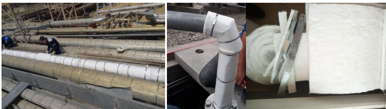
شکل ۱۴- نصب سریع و راحت و آنلاین سرد و گرم بلنکتهای آیروزل نانومتخلخل
